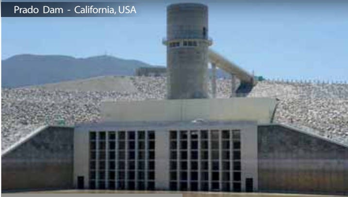
Prado Dam - California, USA
